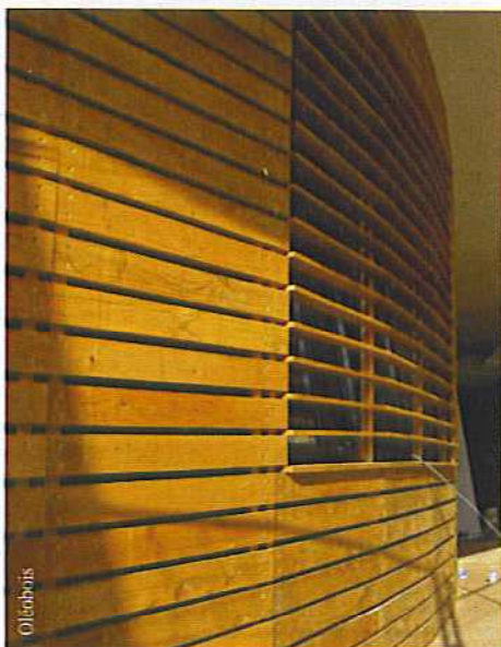
Bardage immergé dans un mélange d'huiles d'origines végétales. Ce traitement, l'oléothermie, permet de conserver la durabilité naturelle du bois dans le temps et d'accroître sa stabilité dimensionnelle.
